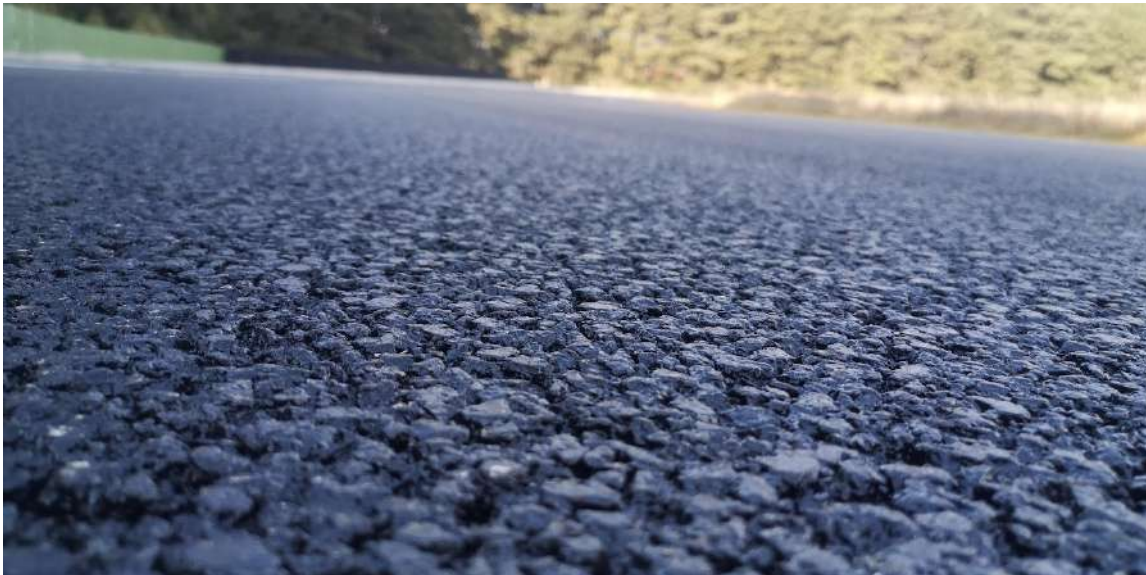
Figura 7. Macro textura y calidad superficial del SMA TN 3/8” colocado en autódromo.
