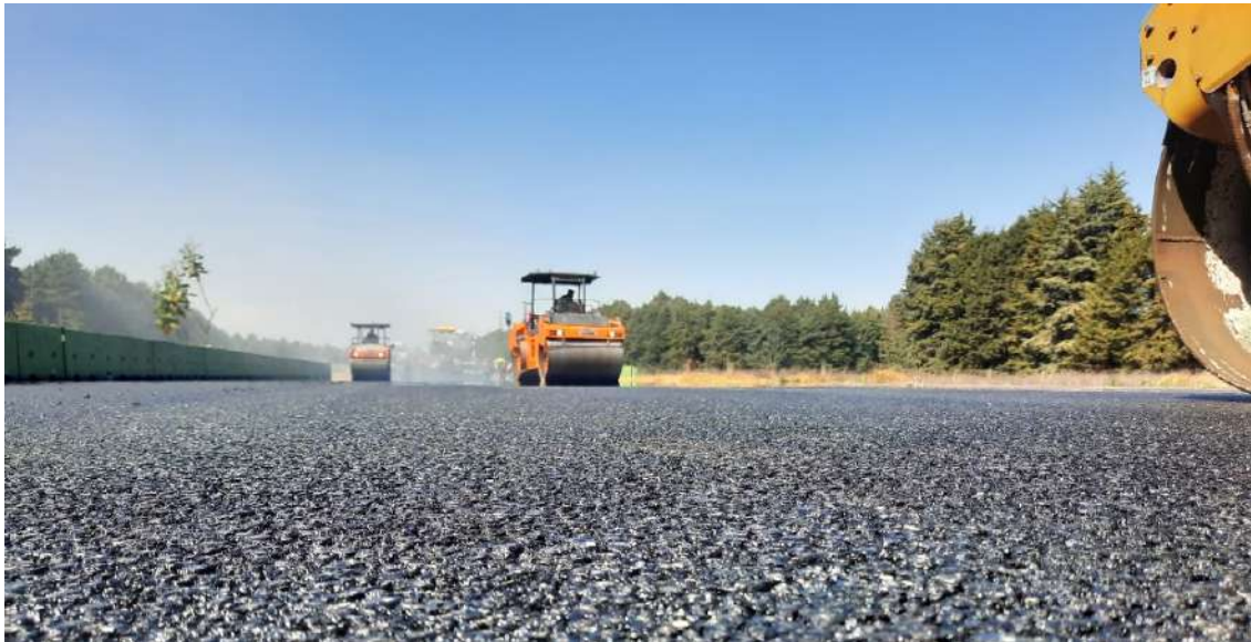
Figura 5. Proceso de compactación, los rodillos trabajando muy cercanos a la pavimentadora. El número de pasadas fue entre dos y tres.
