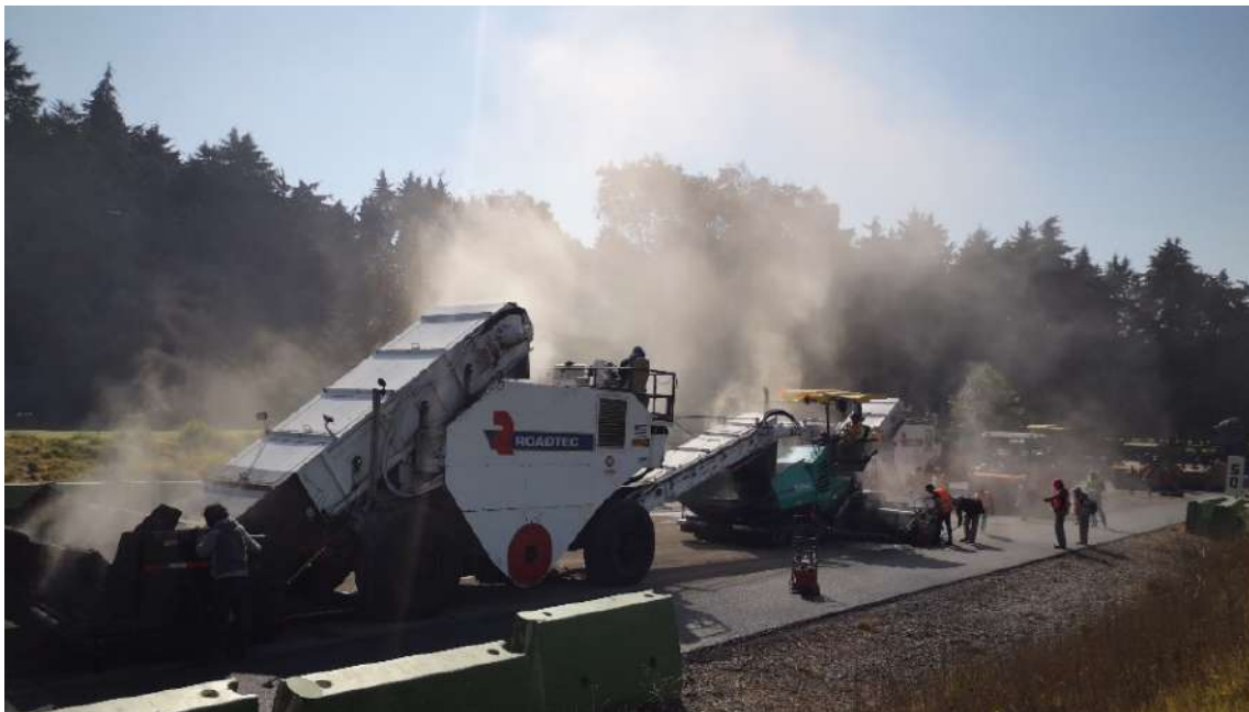
Figura 4: Uso de vehículos de transferencia de mezcla asfáltica entre el camión transportador y la pavimentadora.
