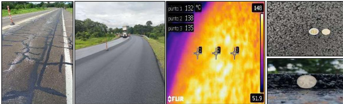
Figura 5. Condiciones de la vía antes y después de la colocación de carpeta ultradelgada con incorporación de NFU y características de la mezcla.
