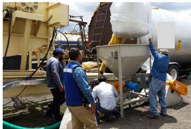
Figura 19. Descarga de filler de aportación en una tolva para alimentarse con soplador
